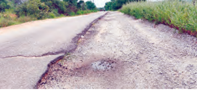
రాజంపేట - రాయచోటి రహదారి లో నిలిచిపోయిన పనులు
